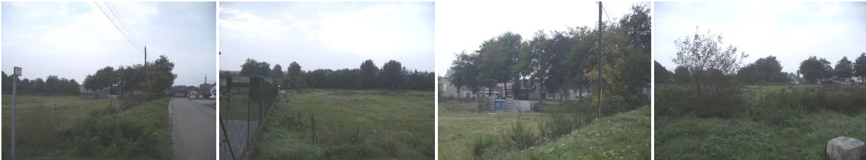
Pijpekop Charles Wellensstraat
